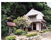
【旧小川家の 土蔵と祠】
