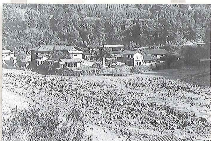
土砂流出により河床の上がった落合地区 建物は役場・診療所
