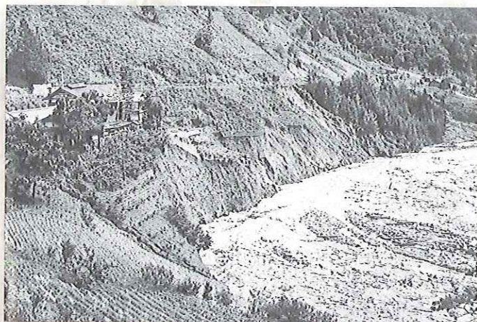
鹿塩川の護岸浸食により農地が流失した北入地区高安付近
