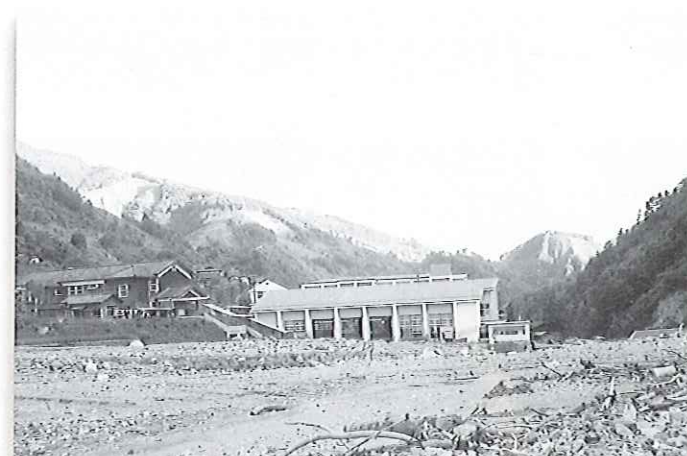
土砂に埋った鹿塩中学校体育館
