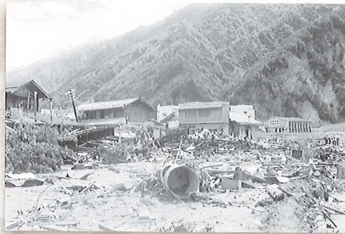
大西山崩落の山津波により破壊された文満地区
