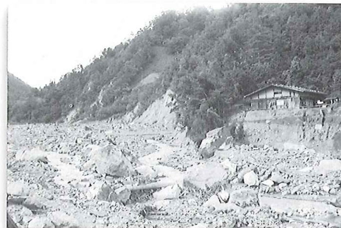
鹿塩川の氾濫により危険にさらされた大栗地区の人家
