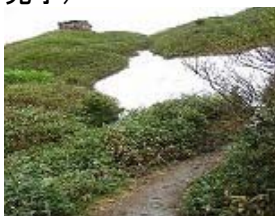
殿ヶ池避難小屋(H27年新築完了)
